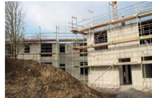
Der Rohbau des Wohnhauses Fotos: Dorothee Blome
